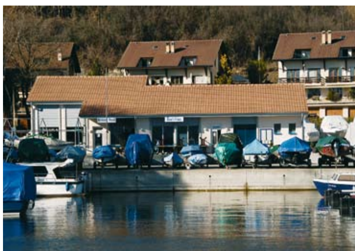
Seit einem Jahr in Betrieb: Bootswerft Nautic + Technic AG in Vallamand.
